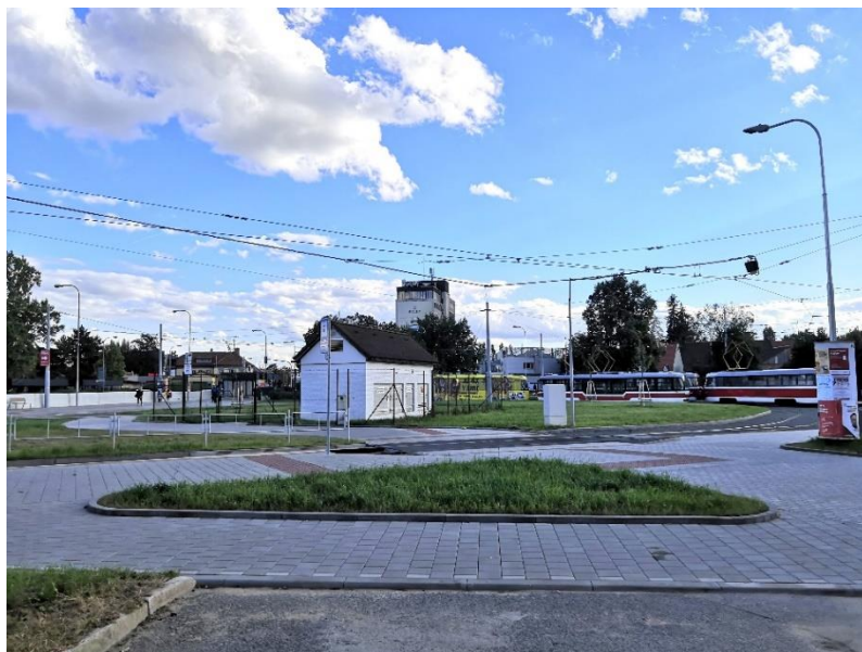
Pohled na tramvajovou smyčku Komárov v Brně po stavebních úpravách
